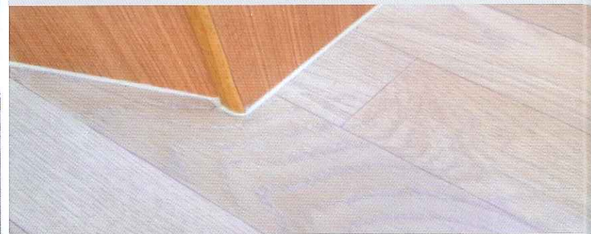
JOINT ÉTANCHÉITÉ AU SOL WATERTIGHT FLOOR JOINTS
